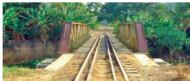
PONTE DE FERRO
