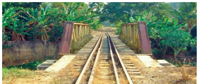
PONTE DE FERRO
