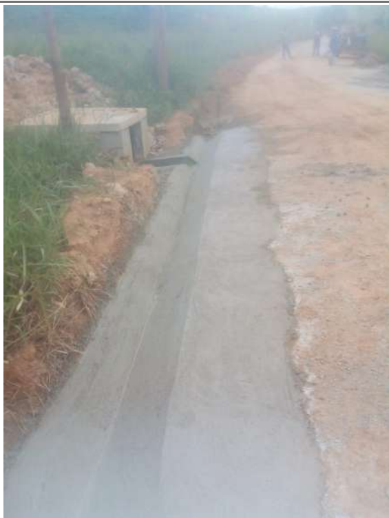
Execução de sarjeta
