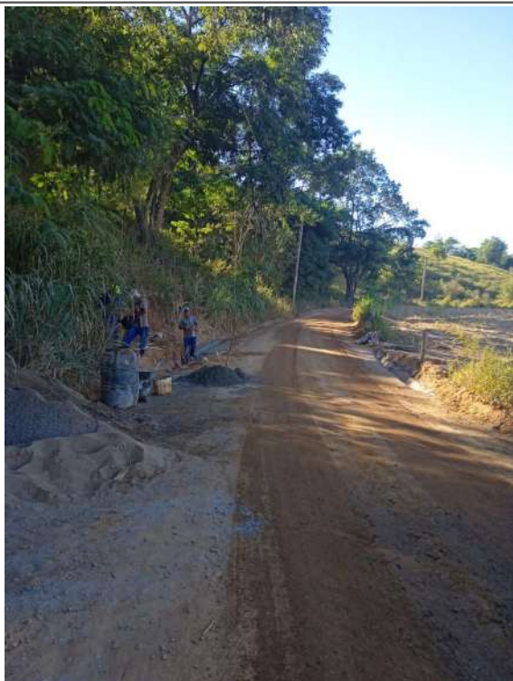
Execução de sarjeta
