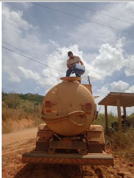
Mistura da solução GloboSolo
