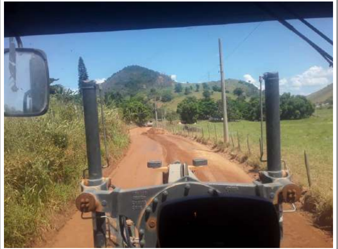
Nivelamento da via
