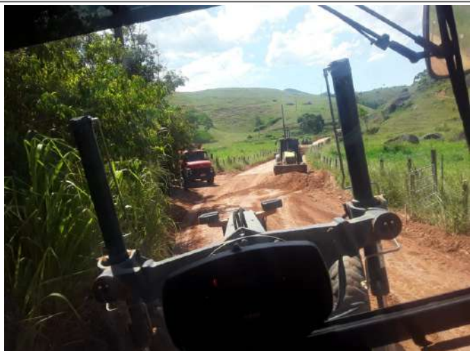
Conformação de aterro
