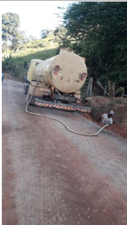
Limpeza na drenagem
