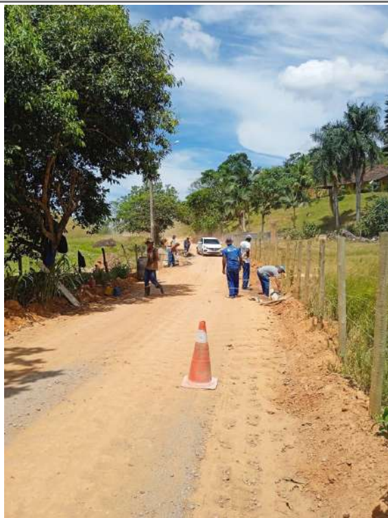
Execução de sarjeta
