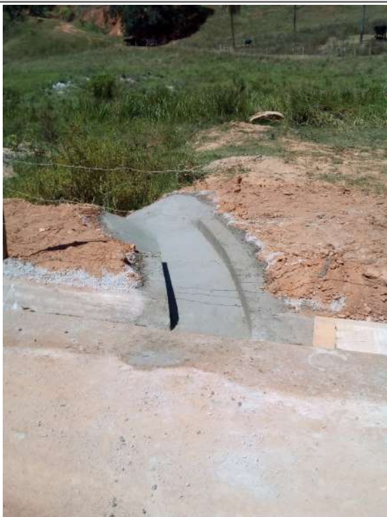
Execução de sarjeta
