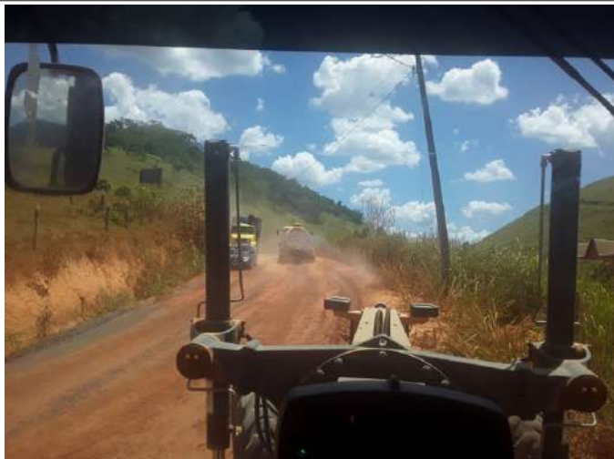
Nivelamento da via e aplicando umidade no solo
