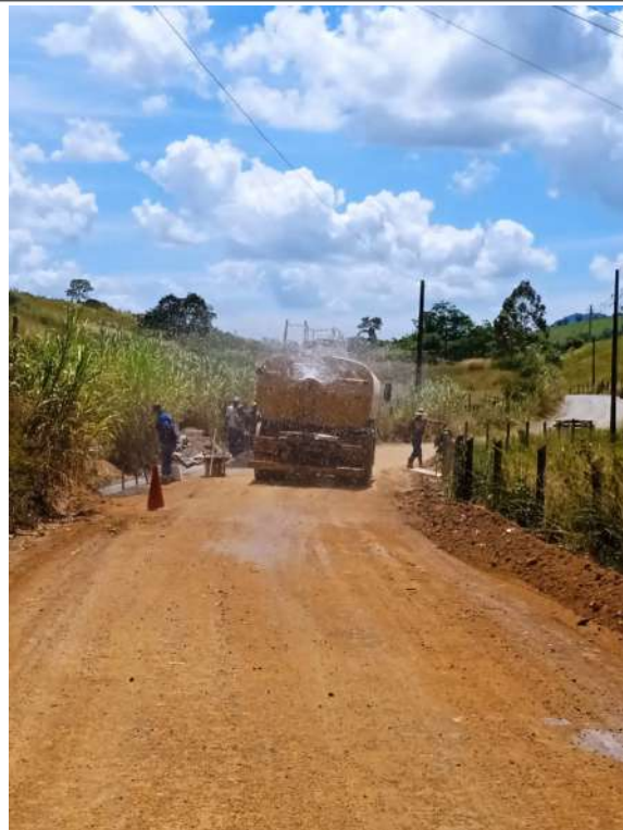
Aplicando umidade para cura do trecho
