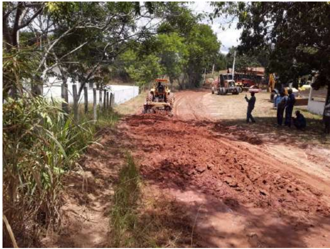
Destorroamento do solo
