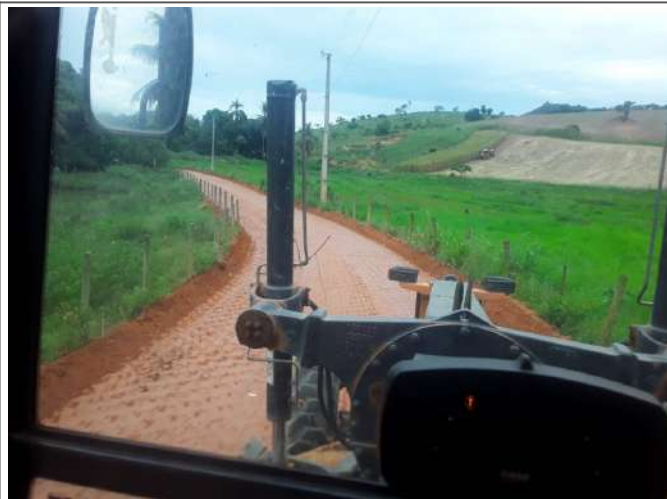
Nivelamento da via
