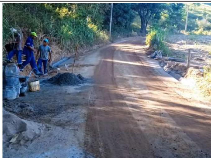
Execução de sarjeta
