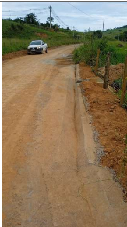
Execução de sarjeta
