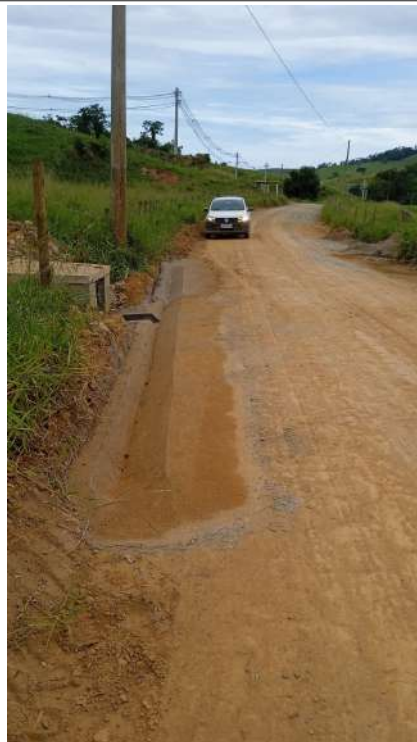
Execução de sarjeta
