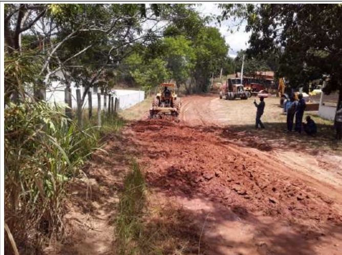
Destorroamento do solo
