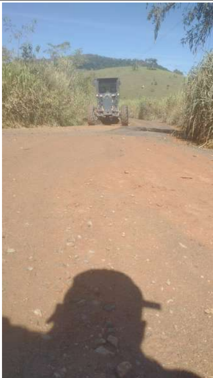
Nivelamento da via
