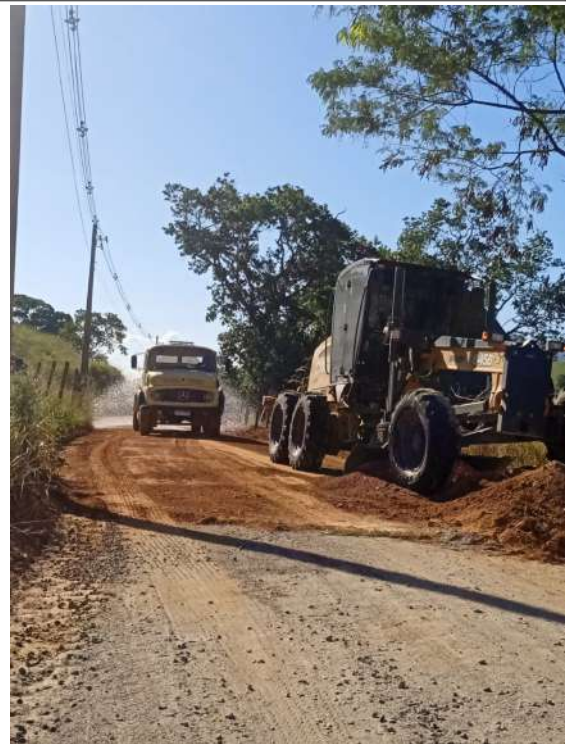
Nivelamento da via e aplicando umidade no trecho
