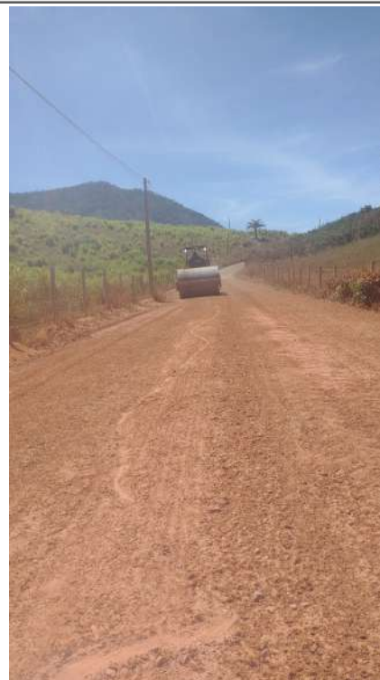
Compactação do trecho
