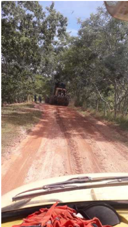
Nivelamento da via
