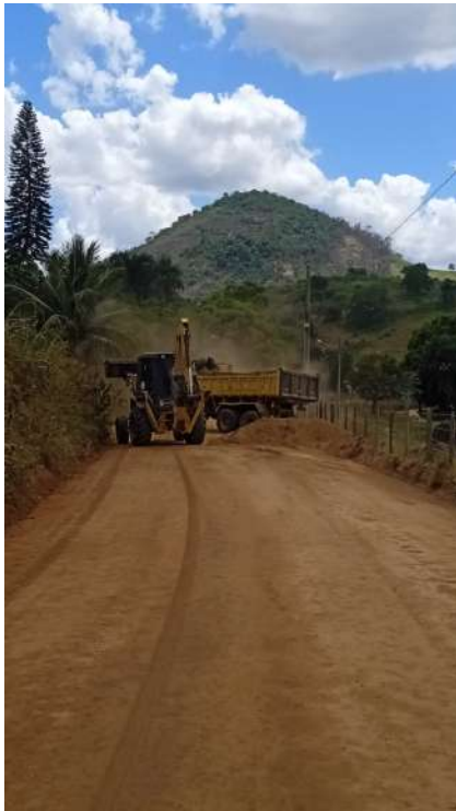
Material para conformação de aterro
