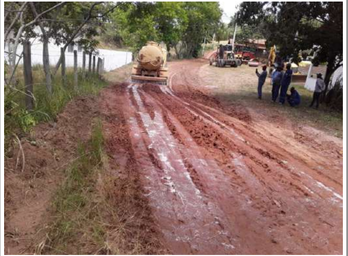
Aplicação da solução GloboSolo na via
