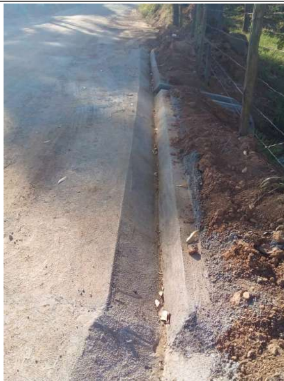
Execução de sarjeta
