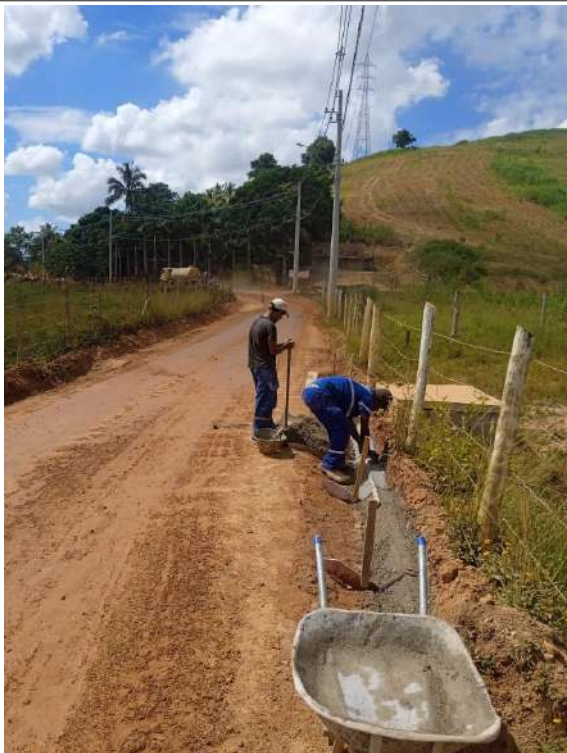
Execução de sarjeta
