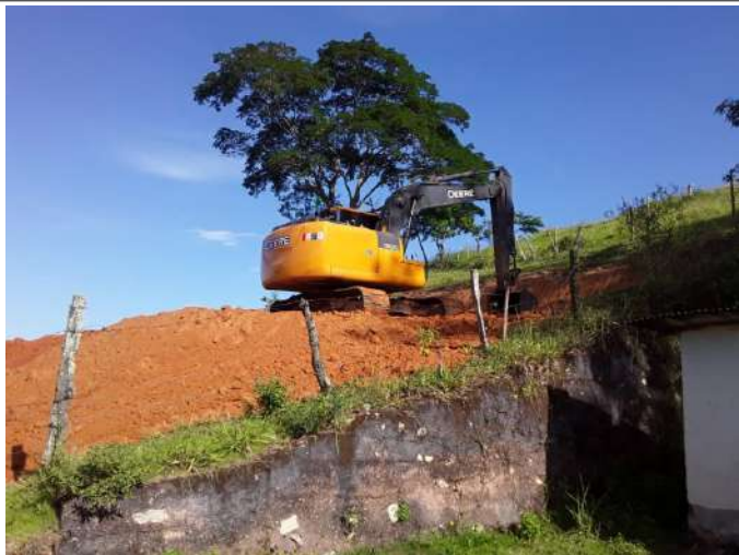
Retirada de material para conformação de aterro
