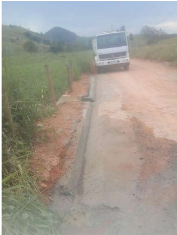
Execução de sarjeta
