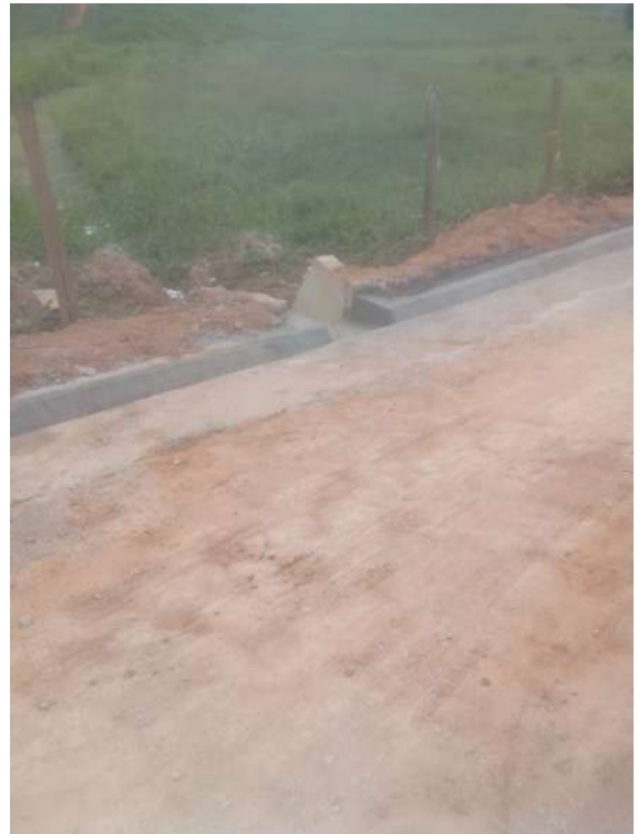
Execução de sarjeta
