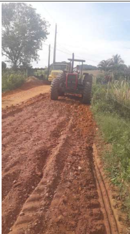
Destorroamento do solo
