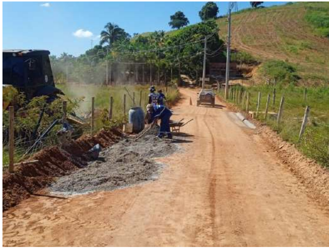
Execução de sarjeta
