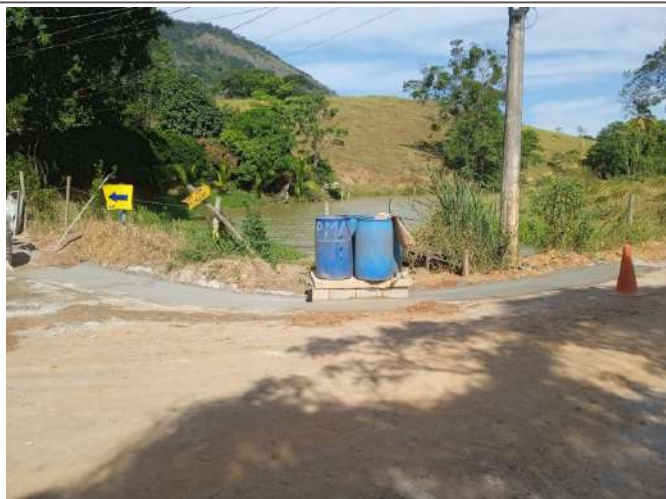
Execução de sarjeta
