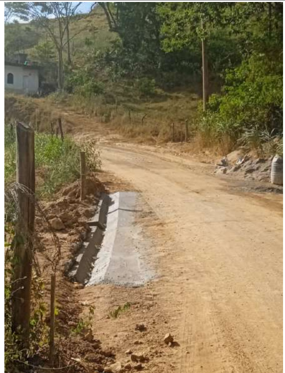
Execução de sarjeta
