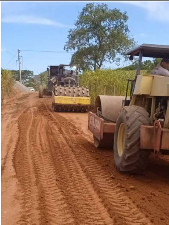
Compactação do trecho
