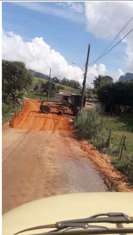
Nivelamento da via
