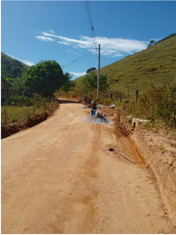
Execução de sarjeta
