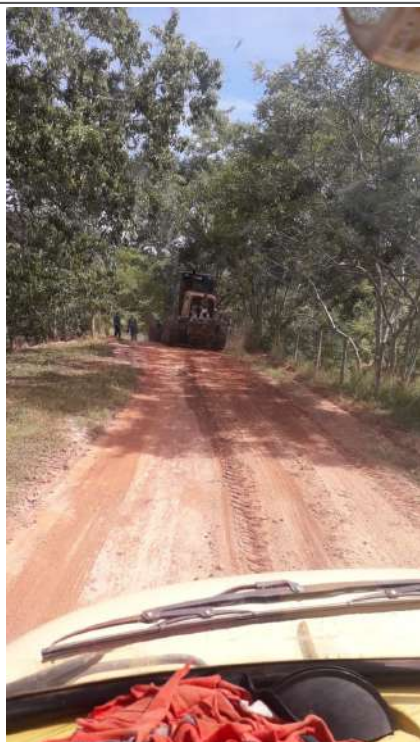
Nivelamento da via
