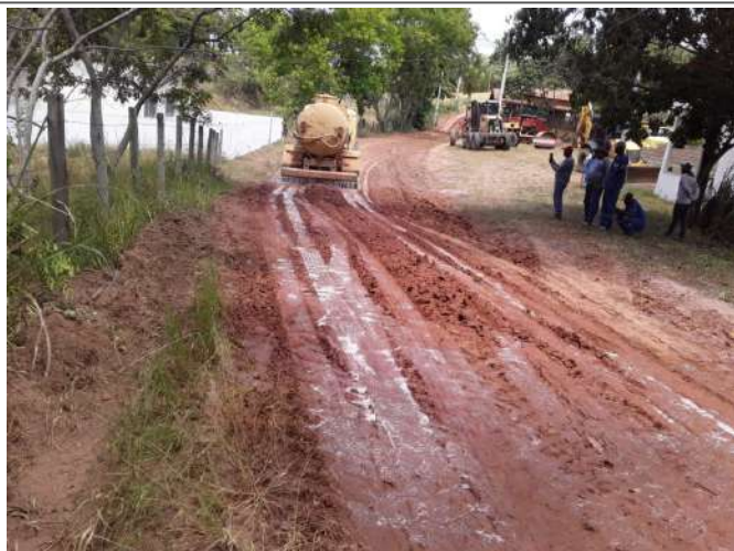
Aplicação da solução GloboSolo na via
