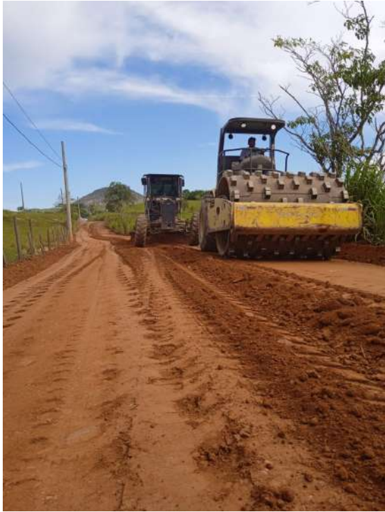
Compactação do trecho
