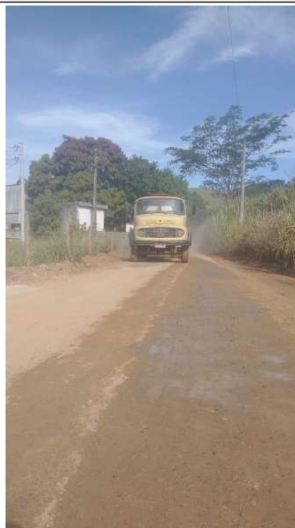
Aplicando umidade para cura do tratamento
