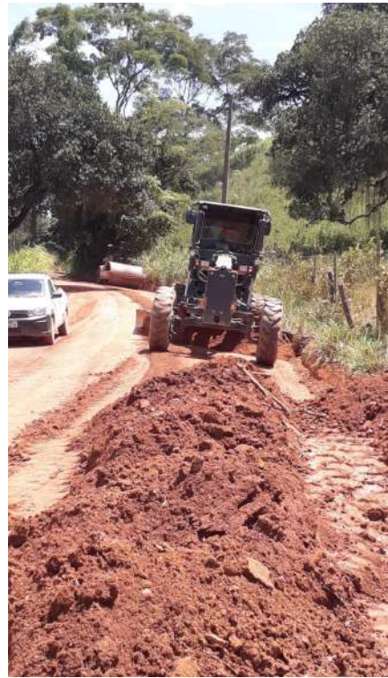
Nivelamento da via
