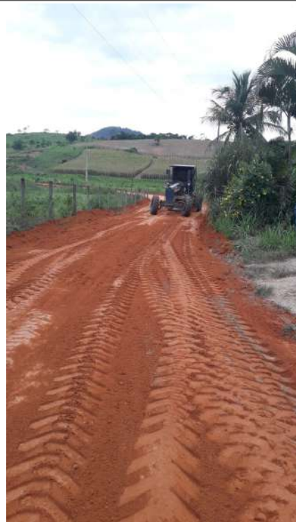
Nivelamento da via
