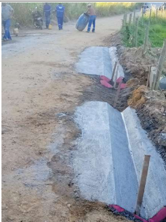
Execução de sarjeta
