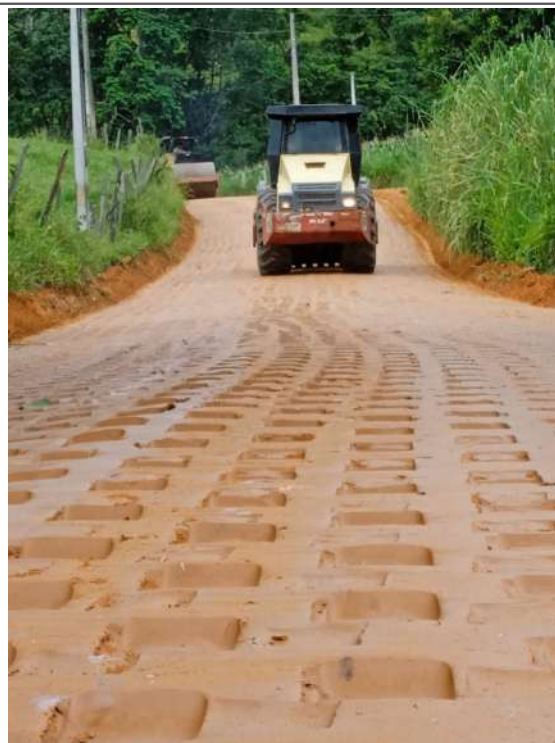
Compactação do trecho
