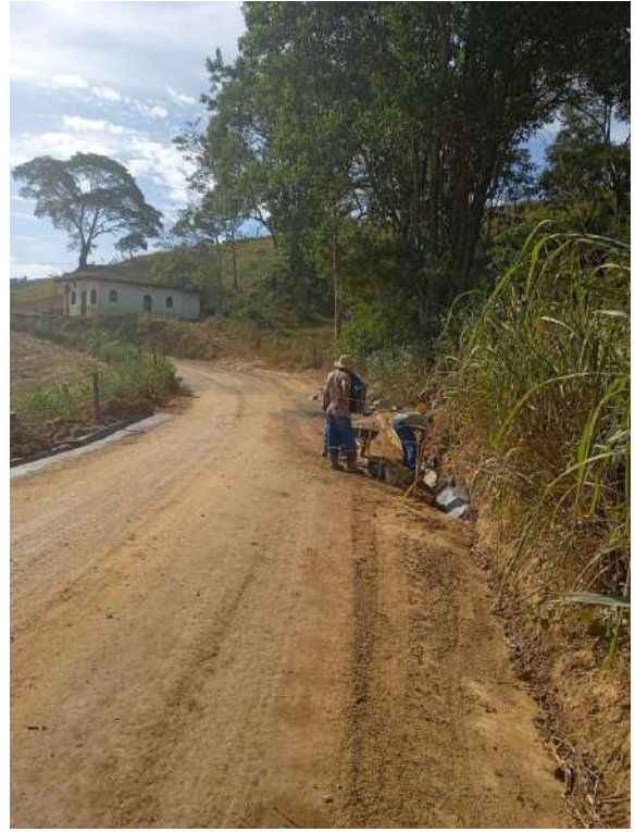
Execução de sarjeta
