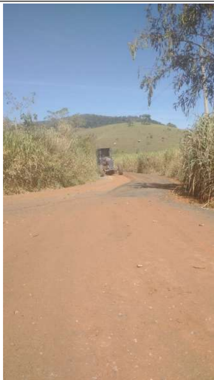
Nivelamento da via
