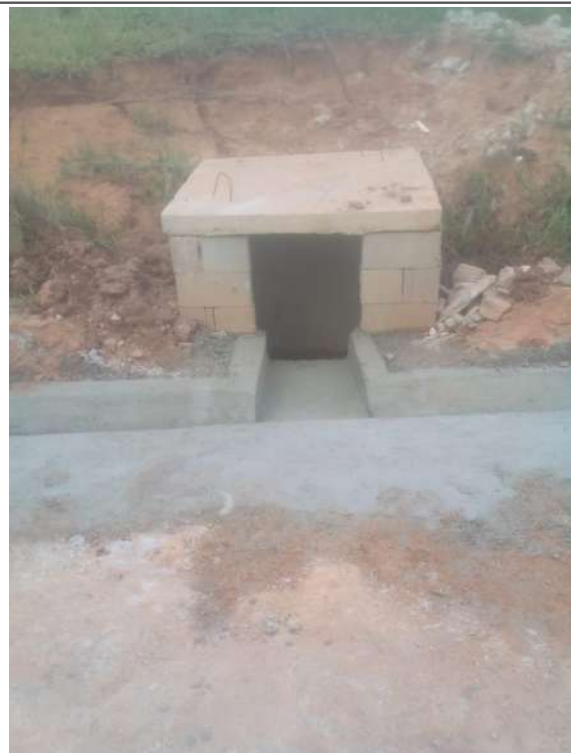
Execução de sarjeta
