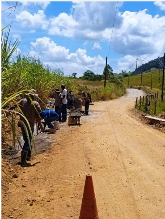
Execução de sarjeta
