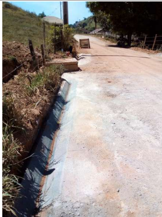
Execução de sarjeta
