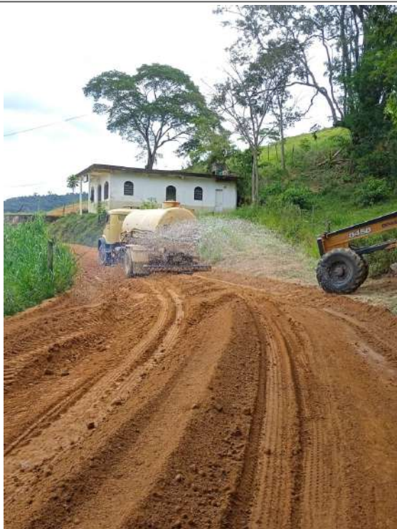
Aplicando umidade no solo
