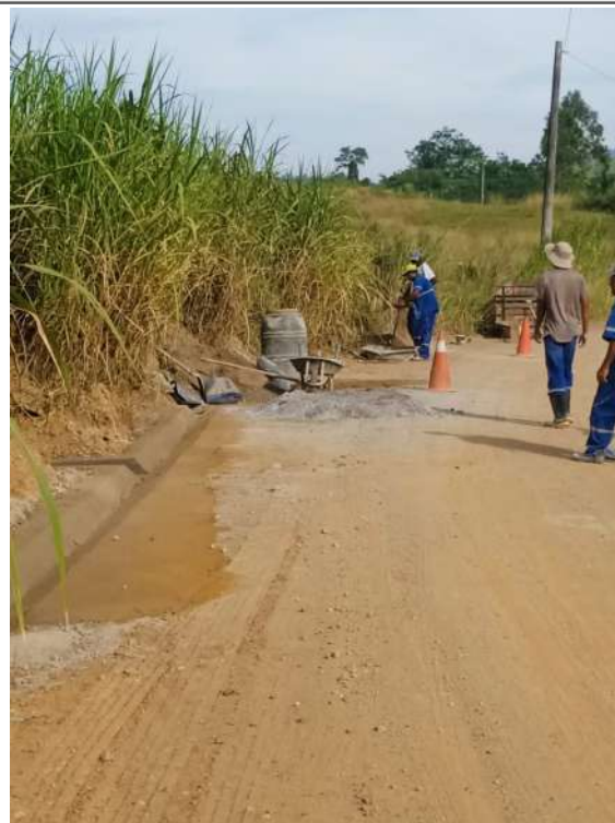
Execução de sarjeta
