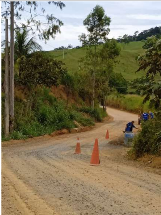
Execução de sarjeta
