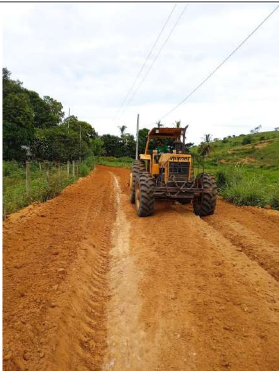
Destorroamento do solo
