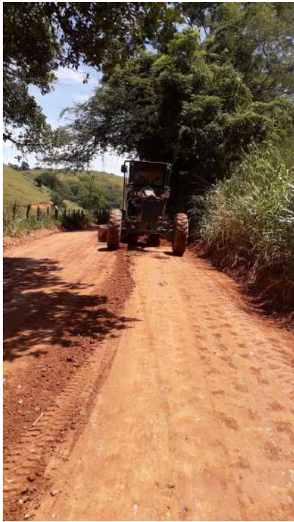
Nivelamento da via
