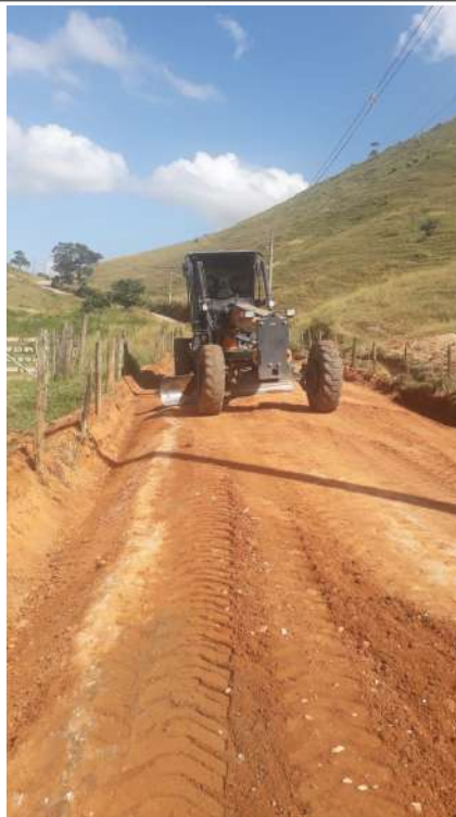
Nivelamento da via
