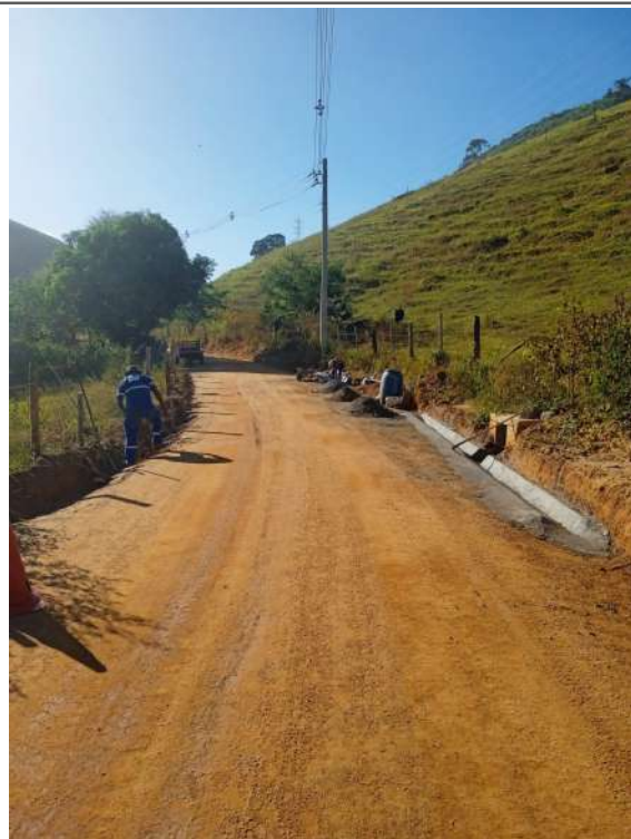
Execução de sarjeta
