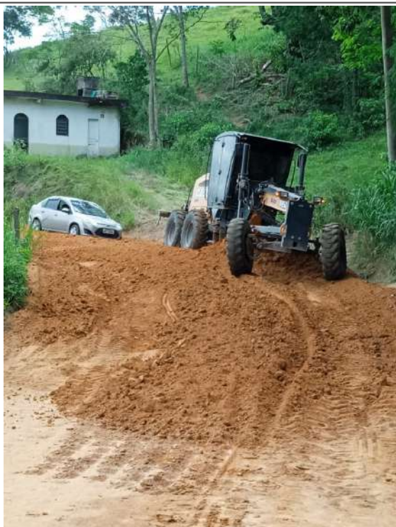
Nivelamento da via
