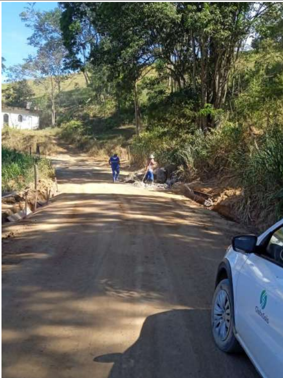
Execução de sarjeta
