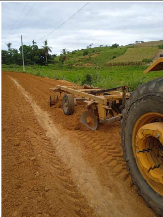
Destorroamento do solo
