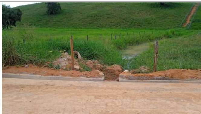
Execução de sarjeta
