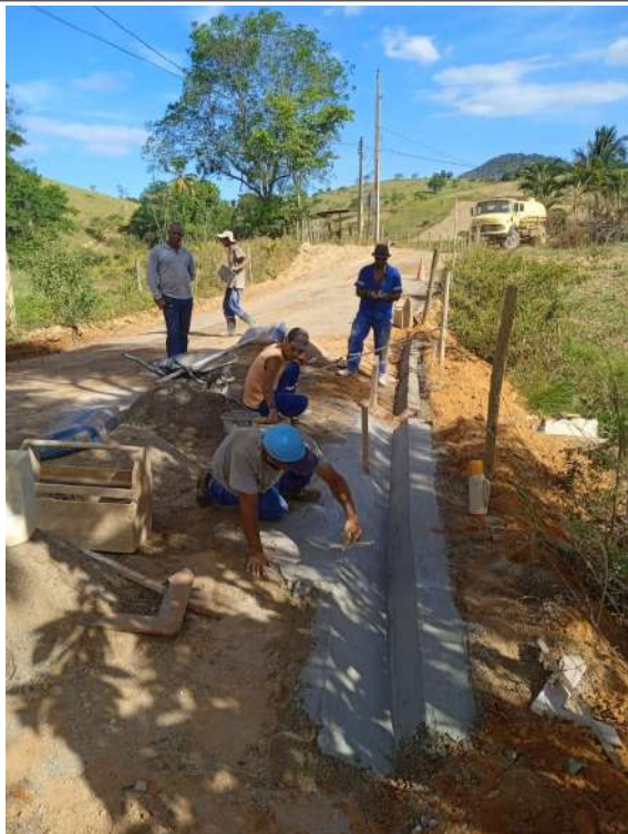
Execução de sarjeta
