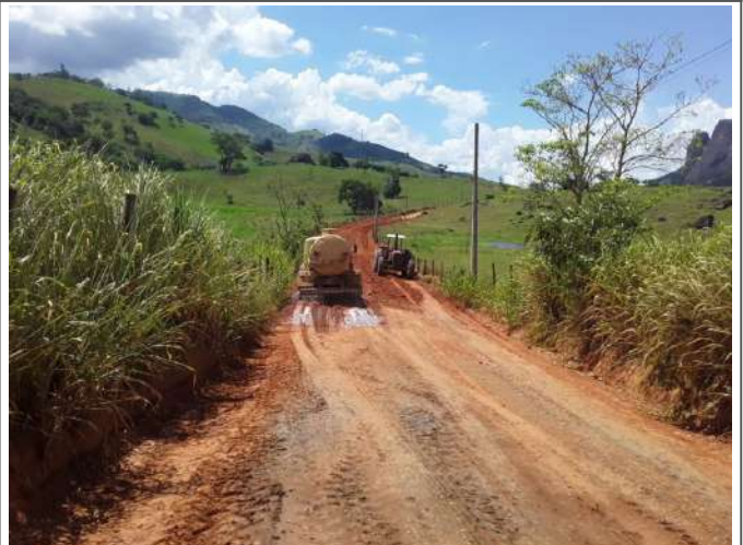
Destorroamento e aplicação da solução GloboSolo no trecho
