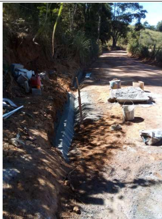
Execução de sarjeta
