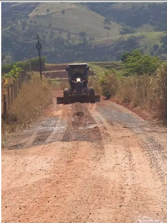
Nivelamento da via
