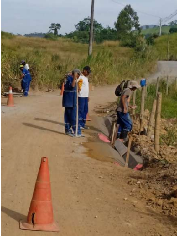
Execução de sarjeta
