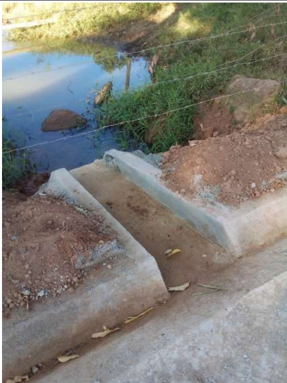
Execução de sarjeta
