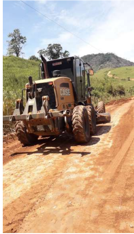
Nivelamento da via
