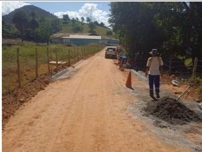
Execução de sarjeta
