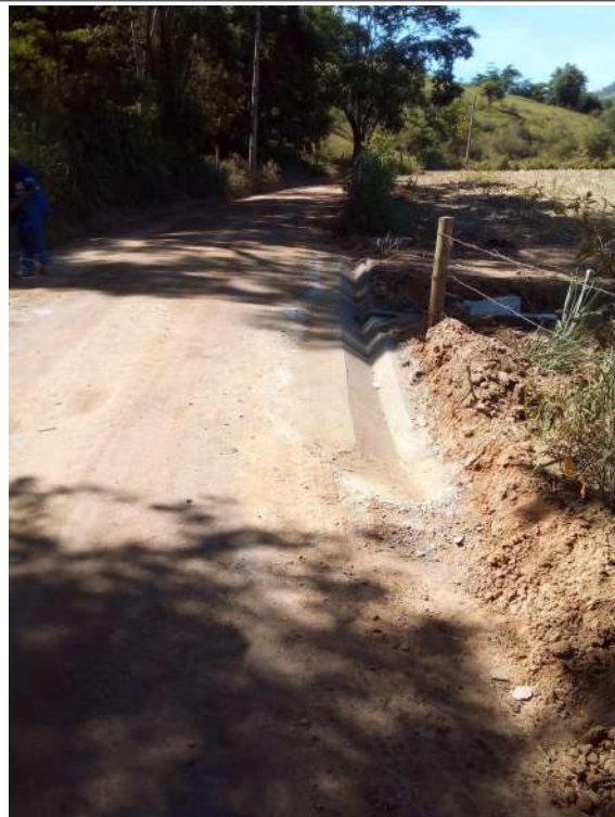
Execução de sarjeta
