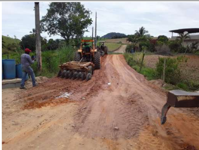
Destorroamento do solo
