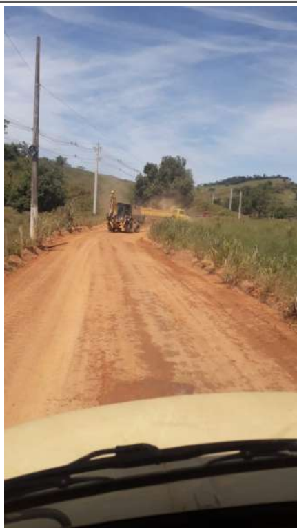
Material para conformação do trecho
