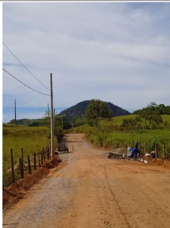
Execução de sarjeta
