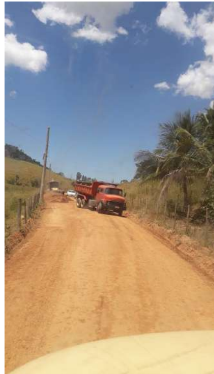
Material para conformação de aterro
