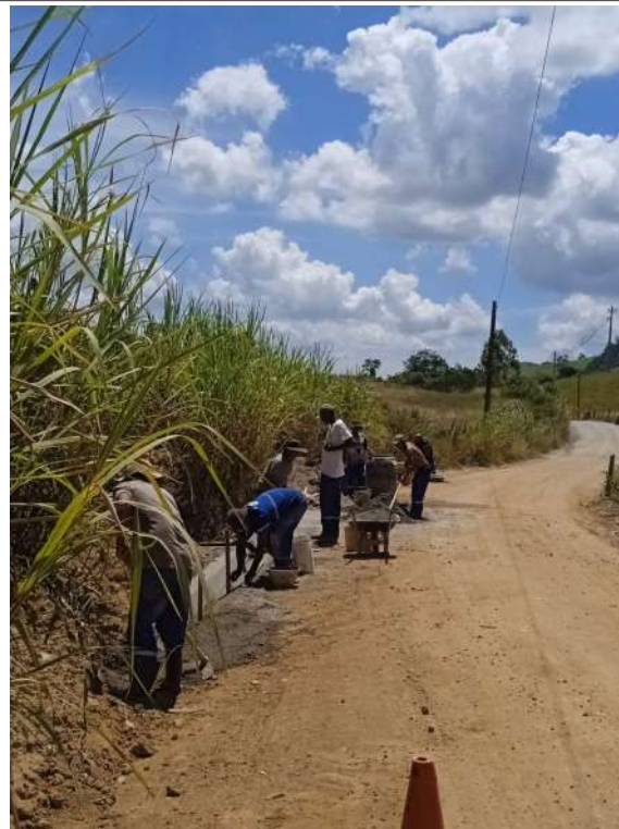
Execução de sarjeta
