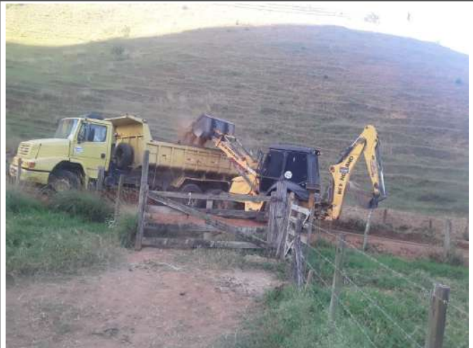
Retirada de material para conformação de aterro
