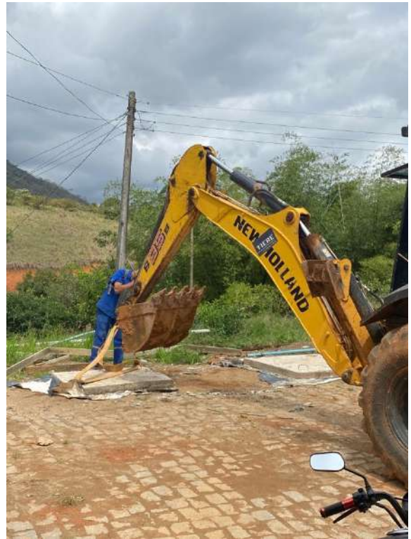
Assentamento de Tampas
