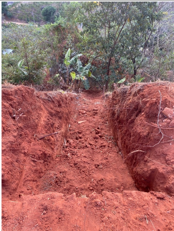
- Limpeza do terreno para execução de descida d'água, E73;
