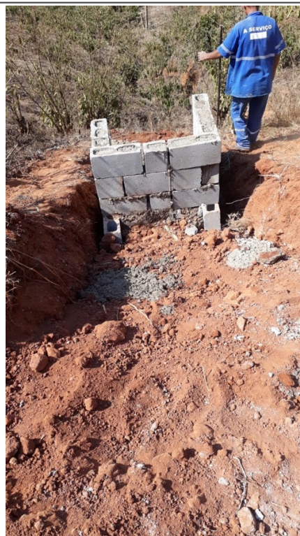
- Execução de Boca de Ala - LE, E66;
