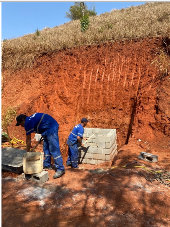
- Finalização de Caixa Coletora, E73;
