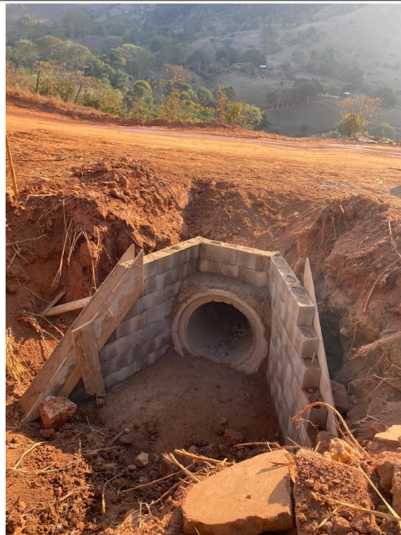
- Execução de Boca de Ala - LD, E66;
