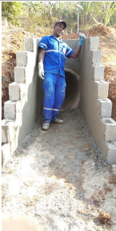
- Acabamento em Boca de Ala E73;
