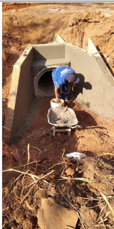
- Acabamento em Boca de Ala E66;
