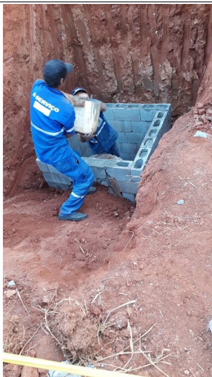
- Execução de Caixa Coletora, E73;
