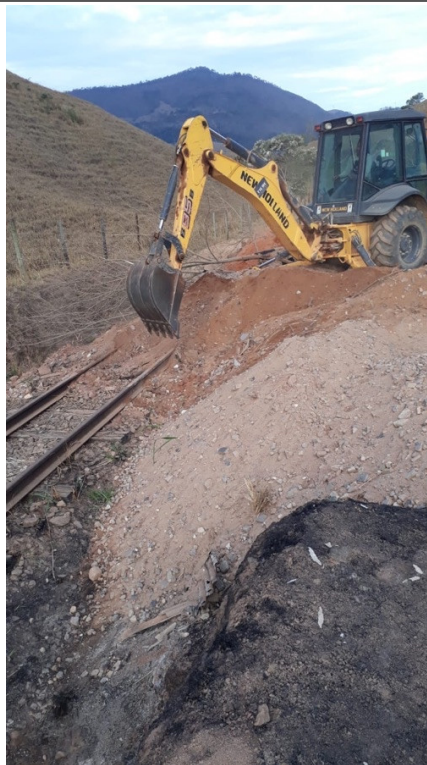
- Limpeza de material;
