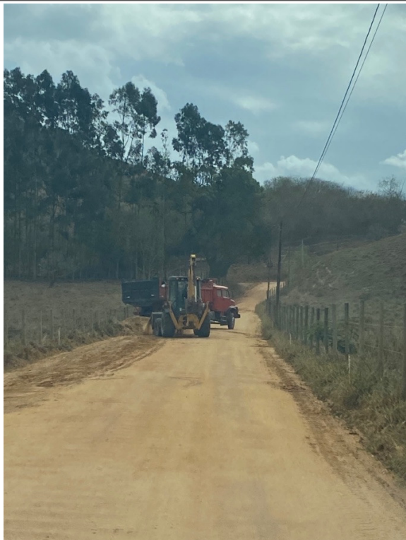
- Limpeza de material;
