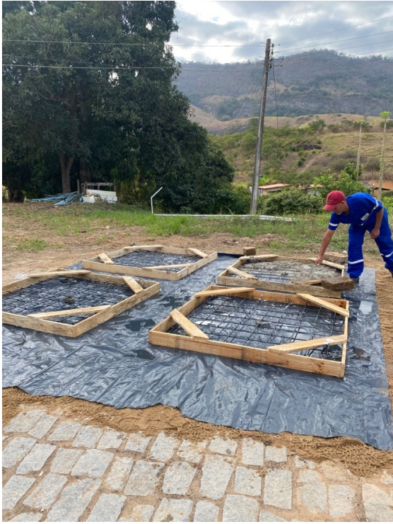
Execução de tampas para caixas coletoras;
