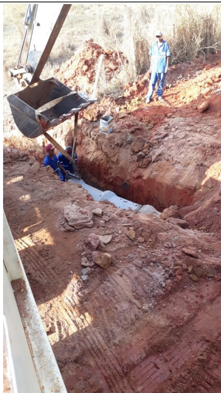
- EXECUÇÃO DE BSTC Ø80 NA E73;
