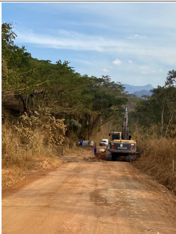
- Execução de BSTC na E50;
