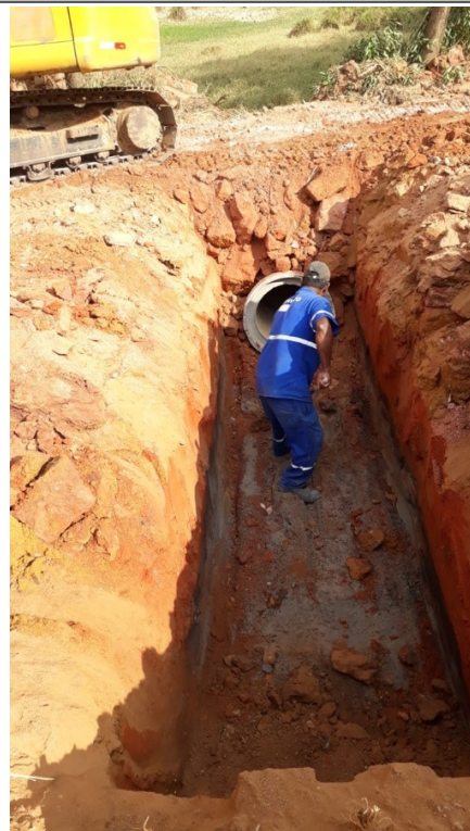
- EXECUÇÃO DE BSTC Ø80 NA E84;
