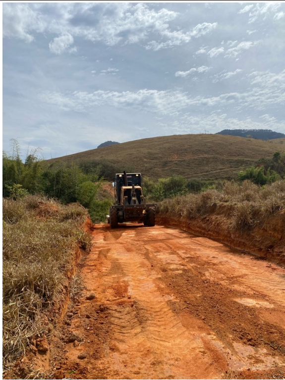
- LIMPEZA DE JAZIDA/EMPRÉSTIMO;
