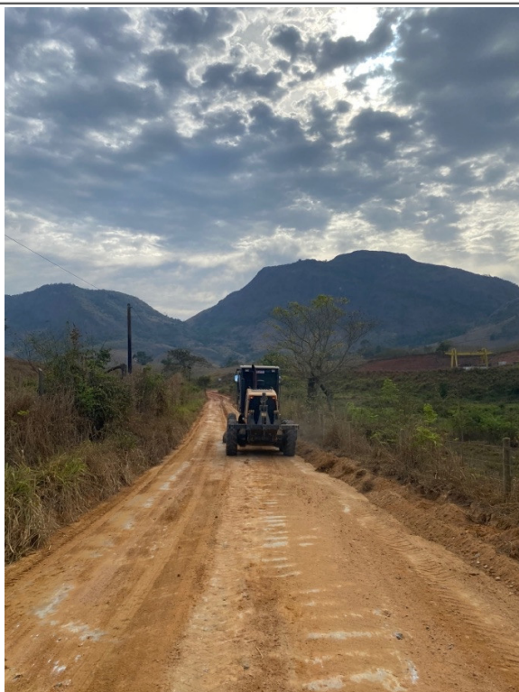
- LIMPEZA DO TRECHO: E140 a E185;
