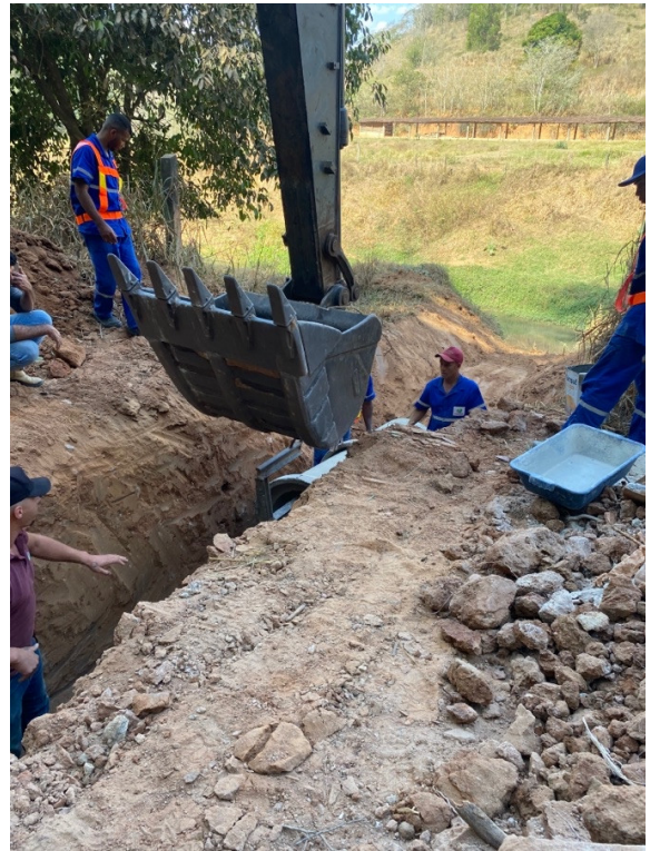
- Motoniveladora em trabalho realizando o assentamento dos bueiros;
