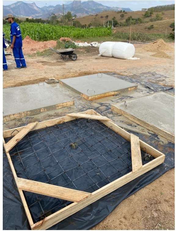
Execução de tampas para caixas coletoras;
