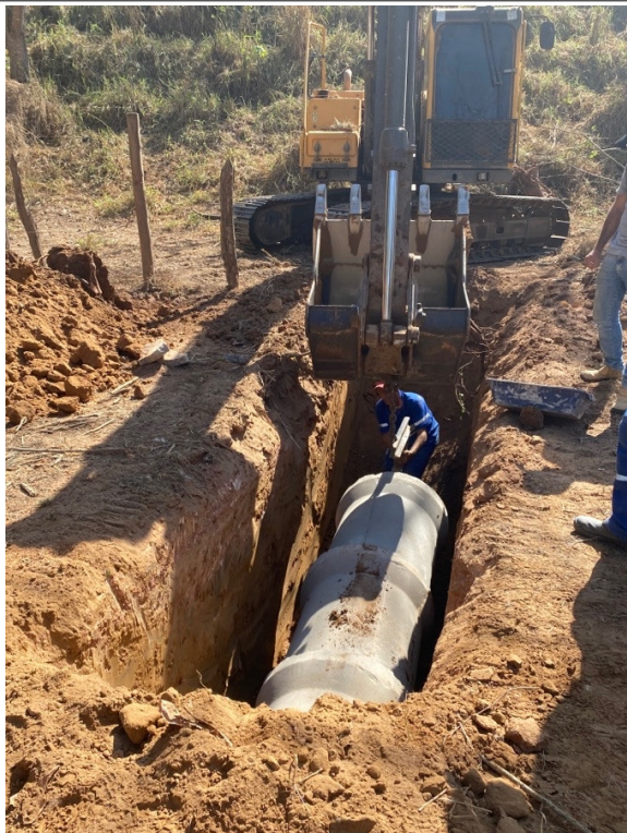
- Execução de BSTC na E27;
