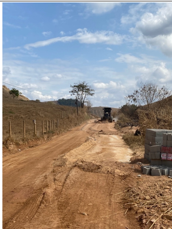
- Limpeza do trecho;
