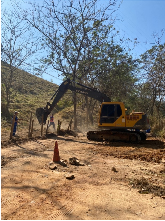
- Execução de BSTC na E27;
