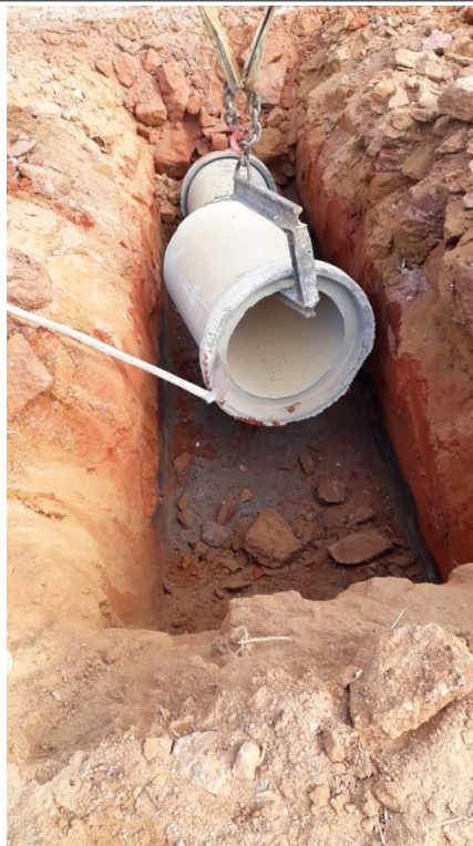
- EXECUÇÃO DE BSTC Ø80 NA E73;
