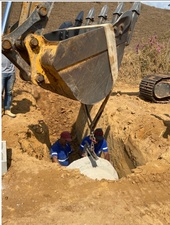
- EXECUÇÃO DE BSTC Ø80 NA E84;
