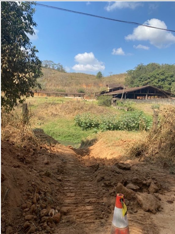
- Abertura da vala para fluxo de água;
