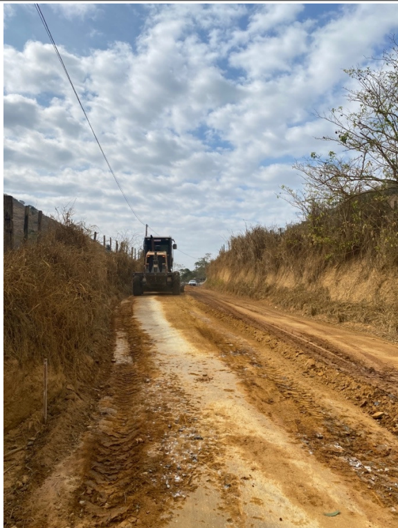
- Limpeza do trecho;
