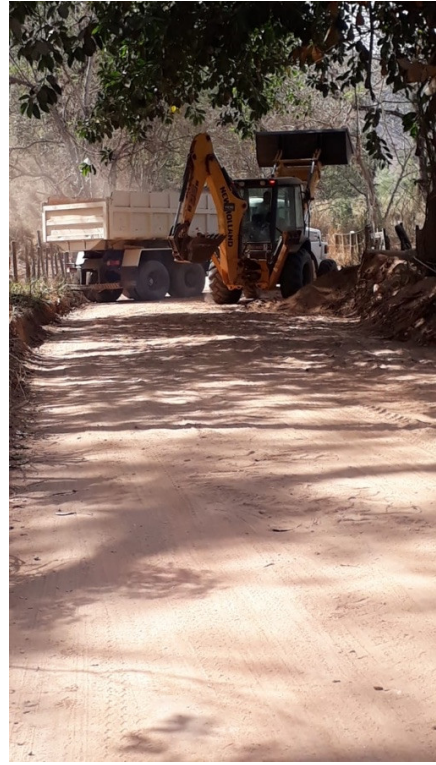
- LIMPEZA DO TRECHO;
