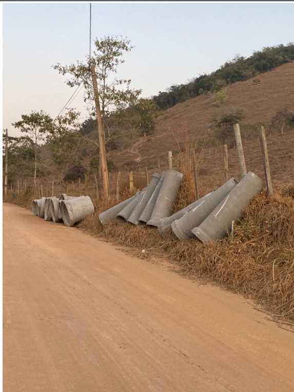
- CHEGADA DE MANILHAS E DISTRIBUIÇÃO DAS MESMAS NOS PONTOS DESTINADOS À UTILIZAÇÃO;
