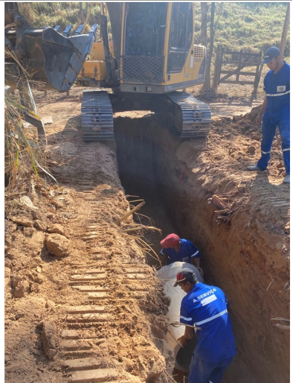
- Execução de BSTC na E27;
