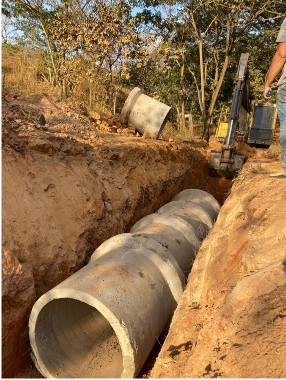
- Execução de BSTC na E50;
