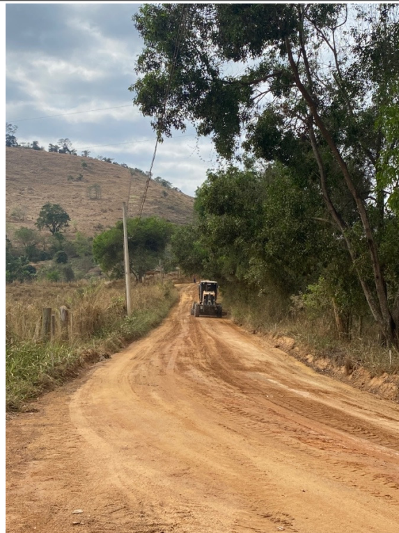
- Limpeza do trecho;
