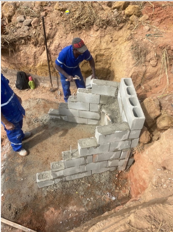
- EXECUÇÃO DE BOCA DE ALA NA E73;
