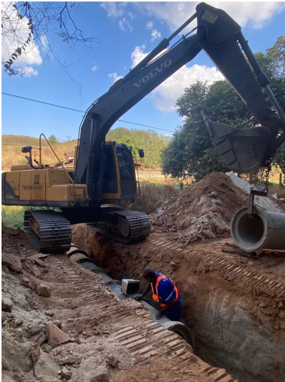
- Motoniveladora em trabalho realizando o assentamento dos bueiros;
