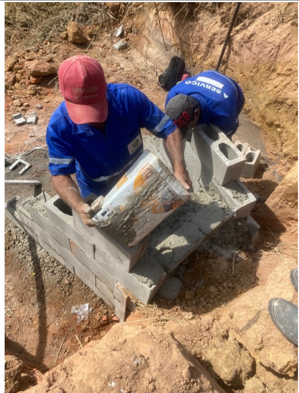
- EXECUÇÃO DE BOCA DE ALA NA E73;
