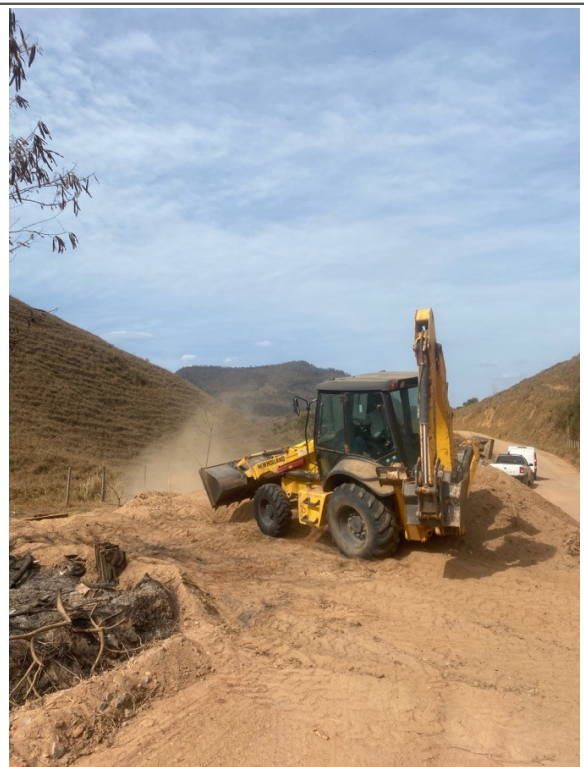
- LIMPEZA DO TRECHO: E140 a E185;
