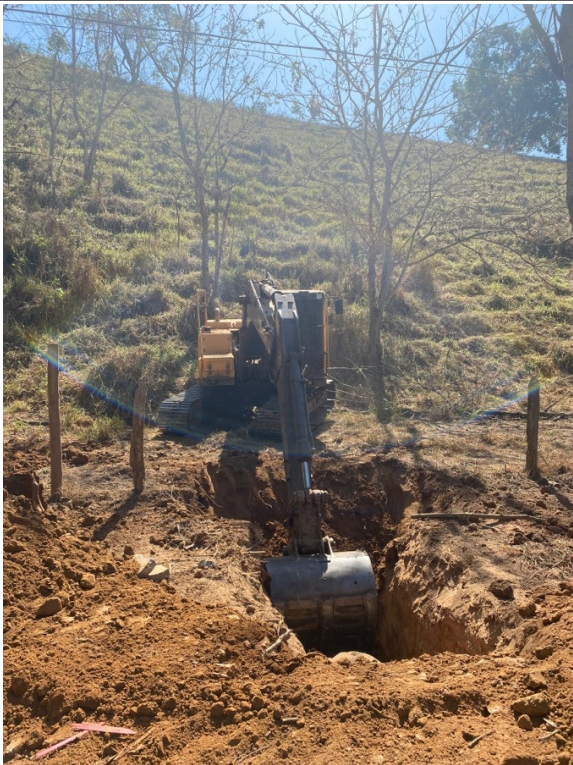
- Execução de BSTC na E27;
