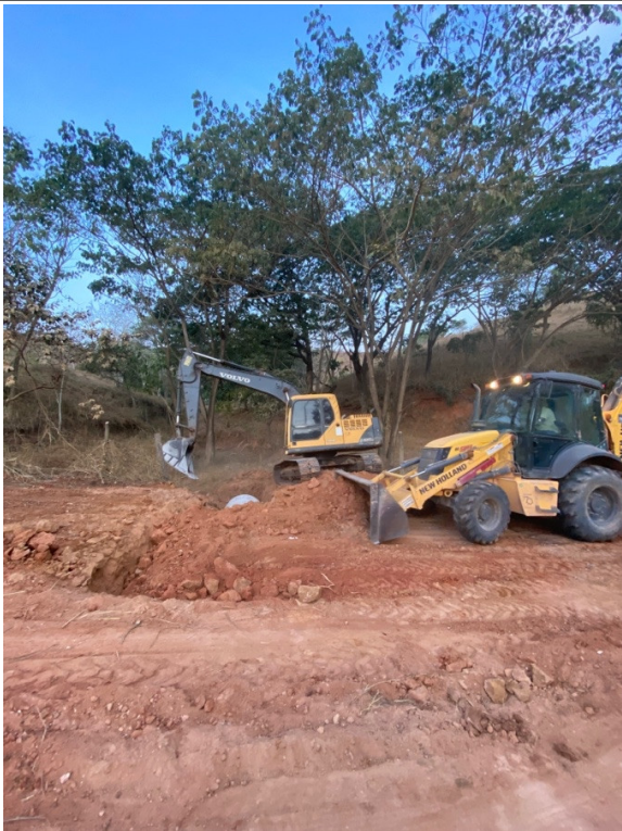
- Execução de BSTC na E50;
