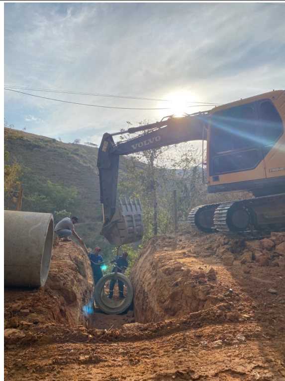
- Execução de BSTC na E50;
