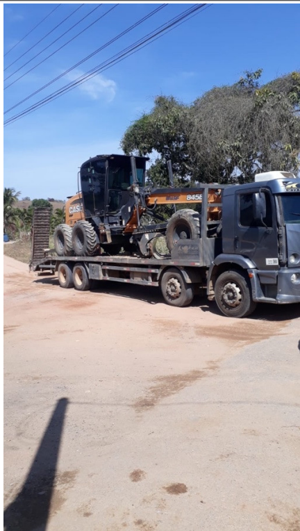
- Chegada de maquinário: motoniveladora.
