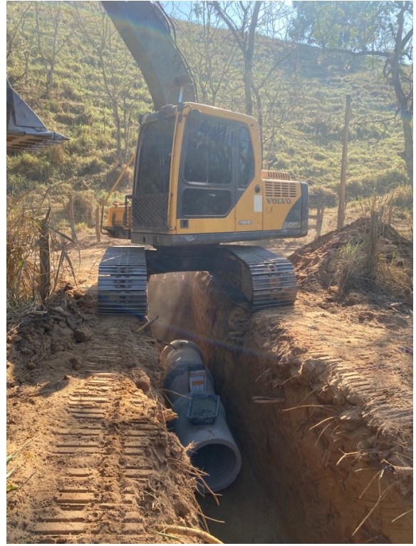
- Execução de BSTC na E27;
