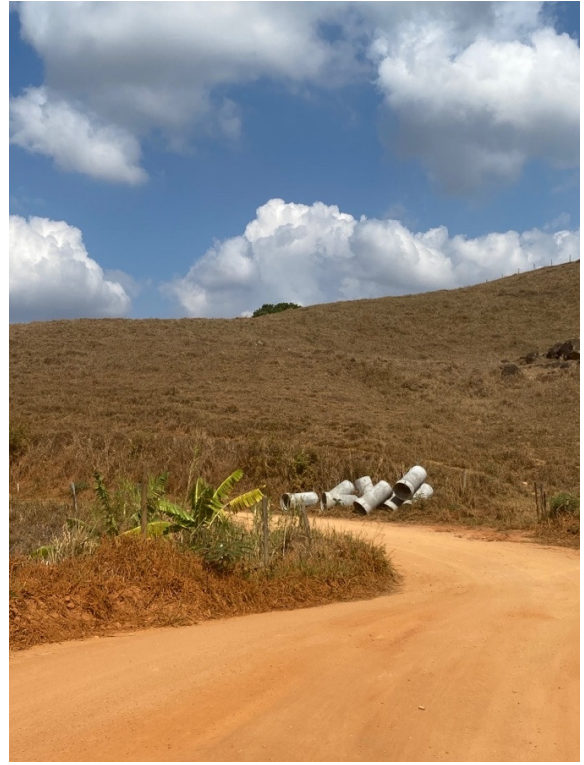
- CHEGADA DE MANILHAS E DISTRIBUIÇÃO DAS MESMAS NOS PONTOS DESTINADOS À UTILIZAÇÃO;
