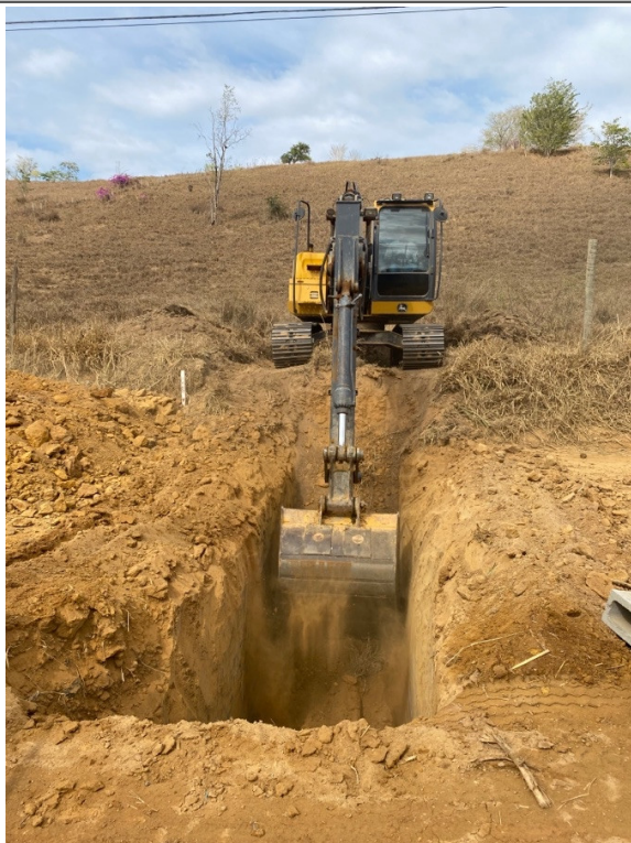
- EXECUÇÃO DE BSTC Ø80 NA E84;
