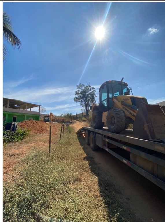
- Troca de maquinário: Retroescavadeira.
