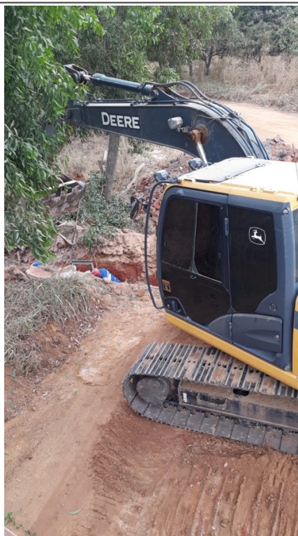
- EXECUÇÃO DE BSTC Ø80 NA E73;
