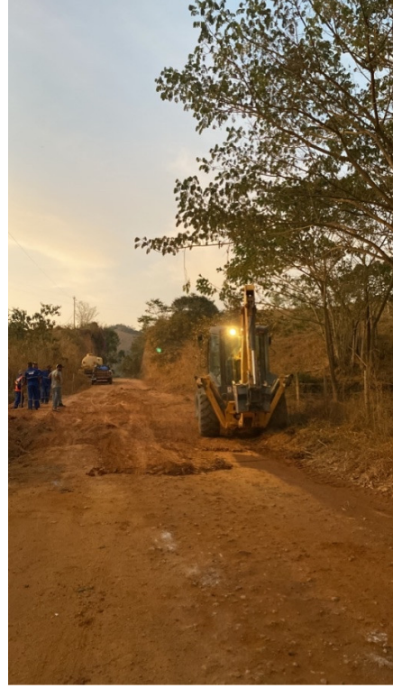
- Execução de BSTC na E50;
