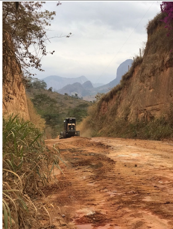
- Limpeza do trecho;
