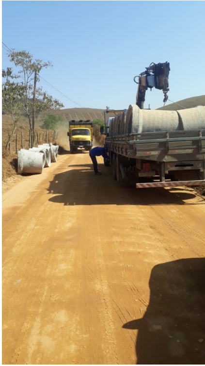
- CHEGADA DE MANILHAS E DISTRIBUIÇÃO DAS MESMAS NOS PONTOS DESTINADOS À UTILIZAÇÃO;
