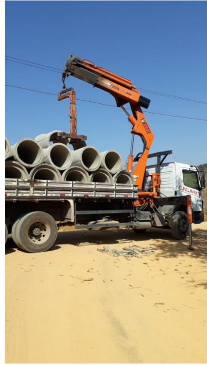
- CHEGADA DE MANILHAS E DISTRIBUIÇÃO DAS MESMAS NOS PONTOS DESTINADOS À UTILIZAÇÃO;
