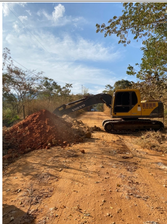
- Execução de BSTC na E50;
