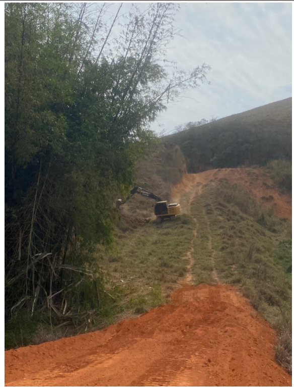
- LIMPEZA DE JAZIDA/EMPRÉSTIMO;
