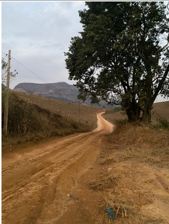
- Limpeza do trecho;
