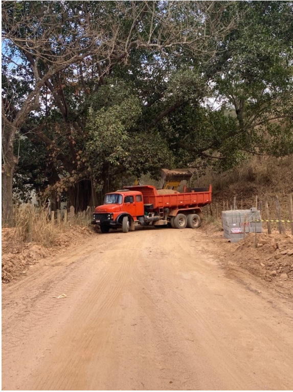
- LIMPEZA DO TRECHO;
