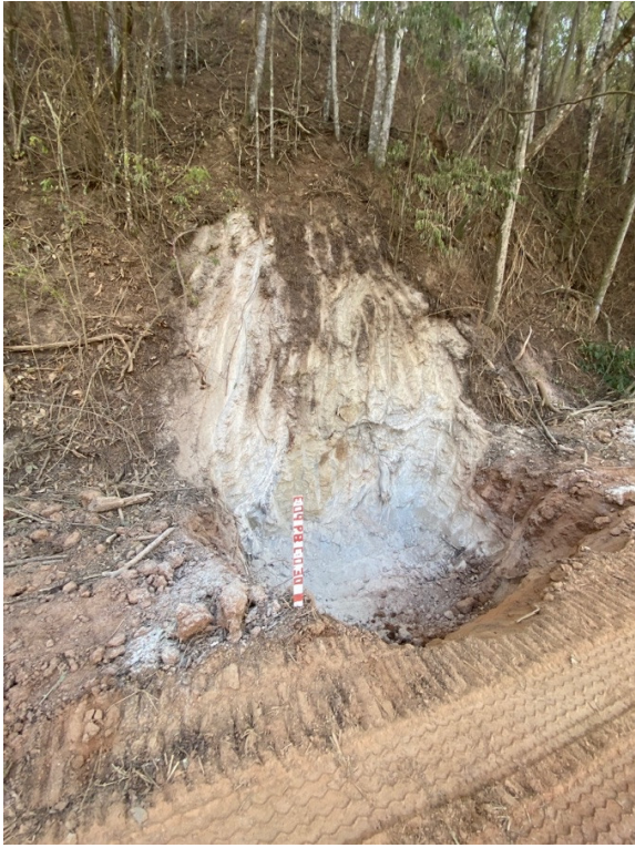
- Abertura para execução de caixa coletora;
