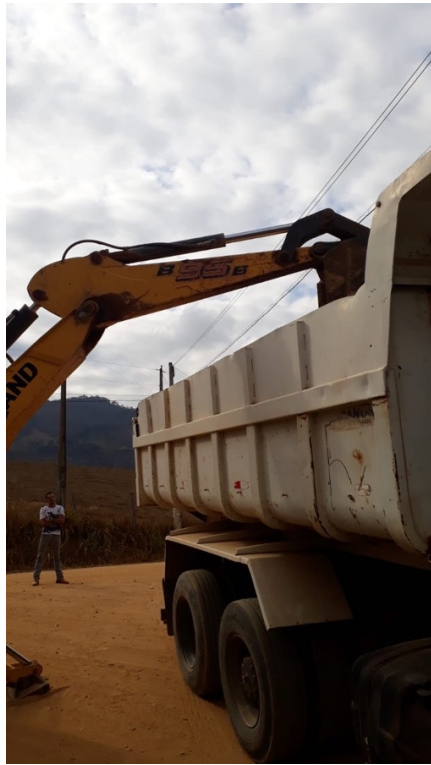
- Transporte de material para ponto de execução.
