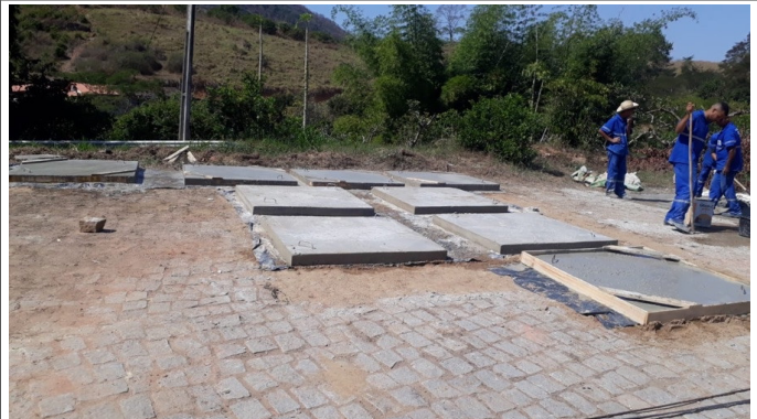
- EXECUÇÃO DE TAMPAS PARA CAIXAS COLETORAS.
