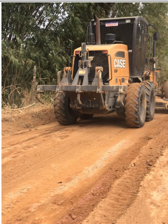
- Limpeza do trecho;
