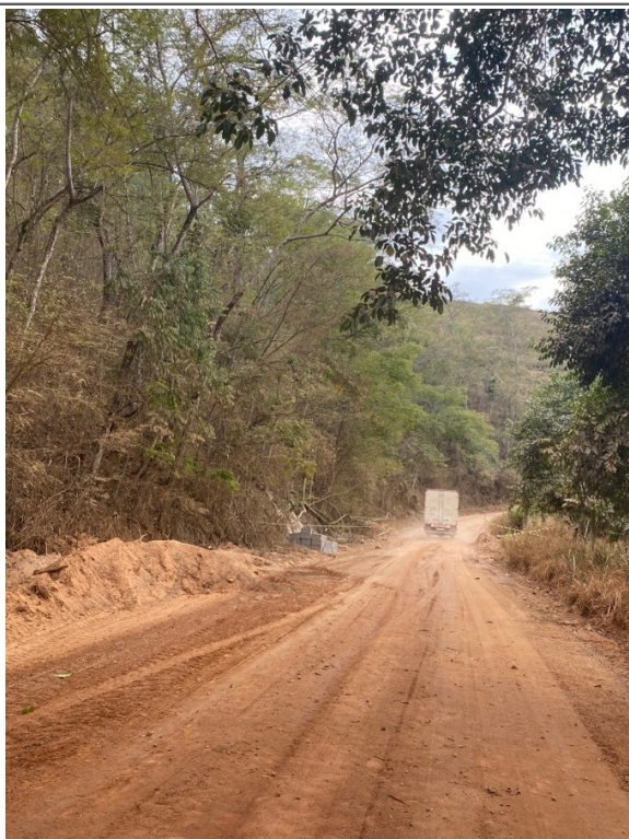
- Limpeza do trecho;
