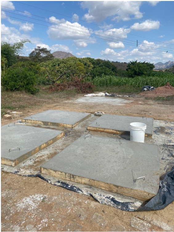
Execução de tampas para caixas coletoras;
