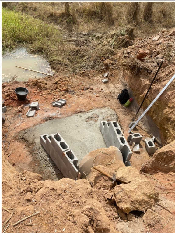
- EXECUÇÃO DE BOCA DE ALA NA E73;
